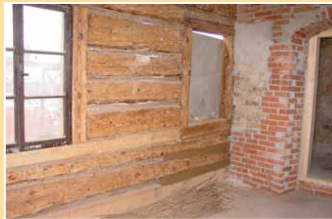
Roubená stavba, Praha (Lignofix Top-OH)
