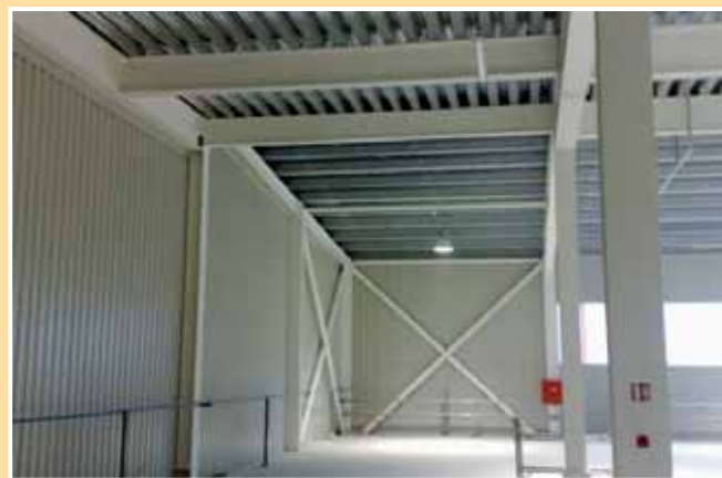
Hala Chemopetrolu Litvínov (Flamizol S)
